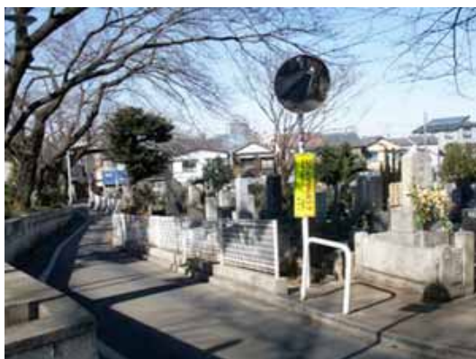
写真 3-14 霊園内を通る道路
